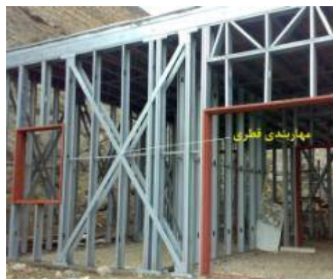
مهاربند تسمه‌ای قطری در قاب سبک فولاد سرد نورد
