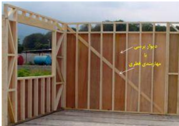
دیوار برشی و مهاربند قطری در قاب سبک چوبی
