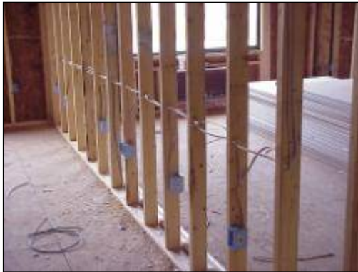
عبور کابل از درون دیوار چوبی
