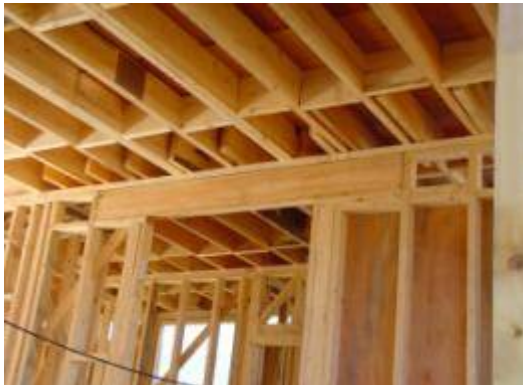
سقف جداکننده طبقات در سیستم چوبی
